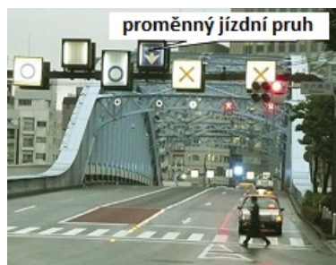
Obrázek 2 — Informace o jízdních pruzích (D.1.3 s přehledem informačních služeb k jízdnímu pruhu)
