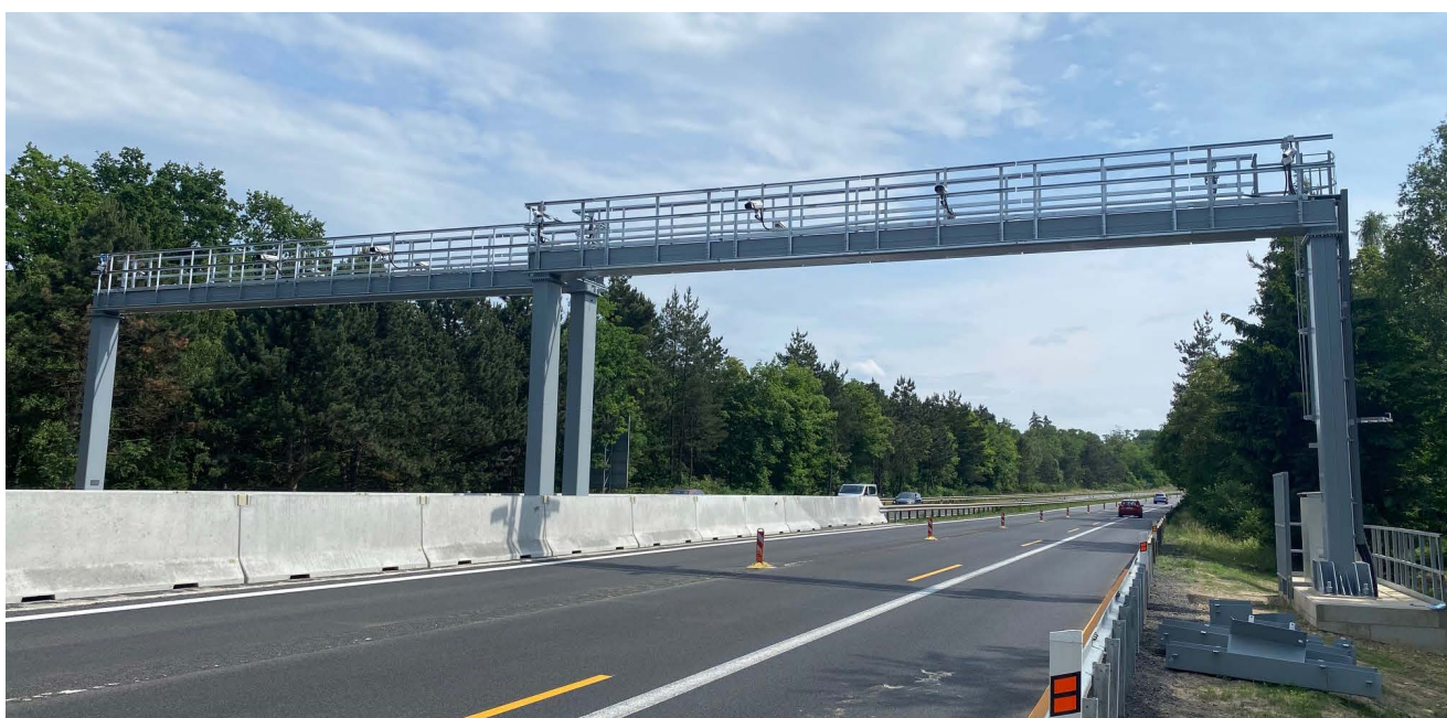
Mýtná brána v místě zúžení jízdního pásu
